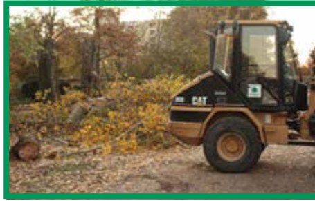
Baubeginn am Popitzweg, Nov. 2020
